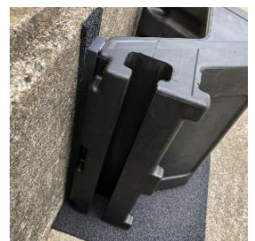
水勾配スペーサー使用
